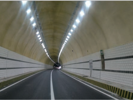
■ 承秦黄土梁子隧道
